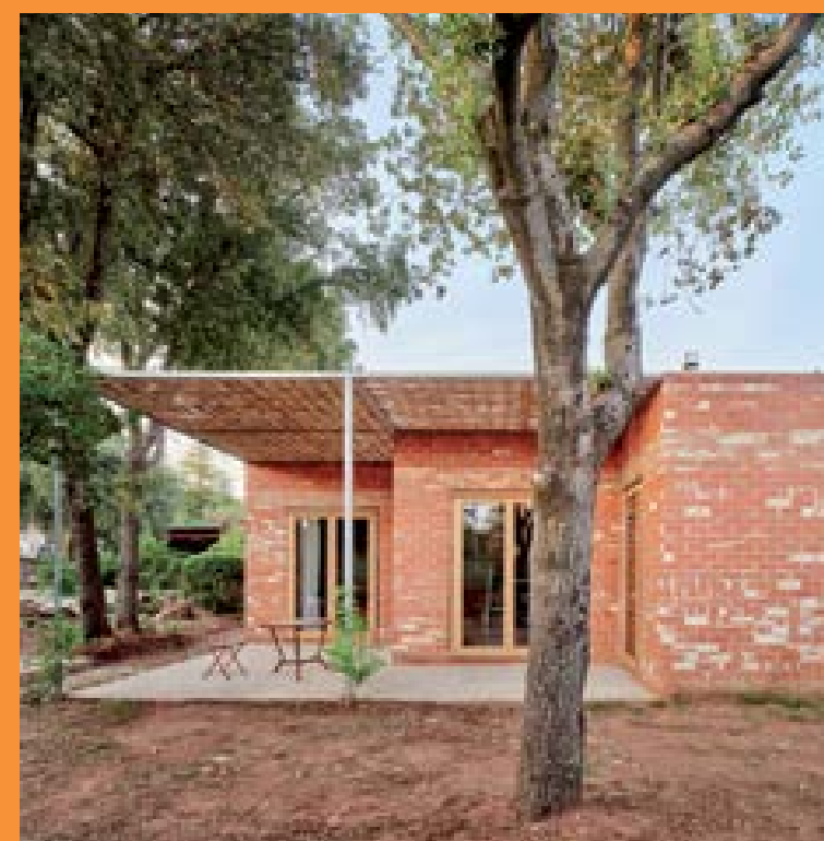
Casa GJ de Alventosa Morell en Matadepera, Barcelona.
